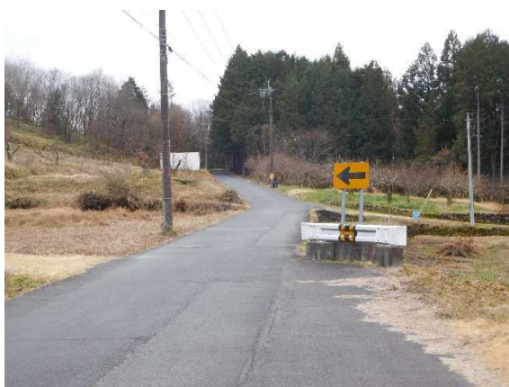
A：ここから一車線になっている
